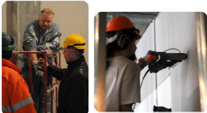
Figur 4. Bilder från arbete med håltagning och gipsuppsättning.
